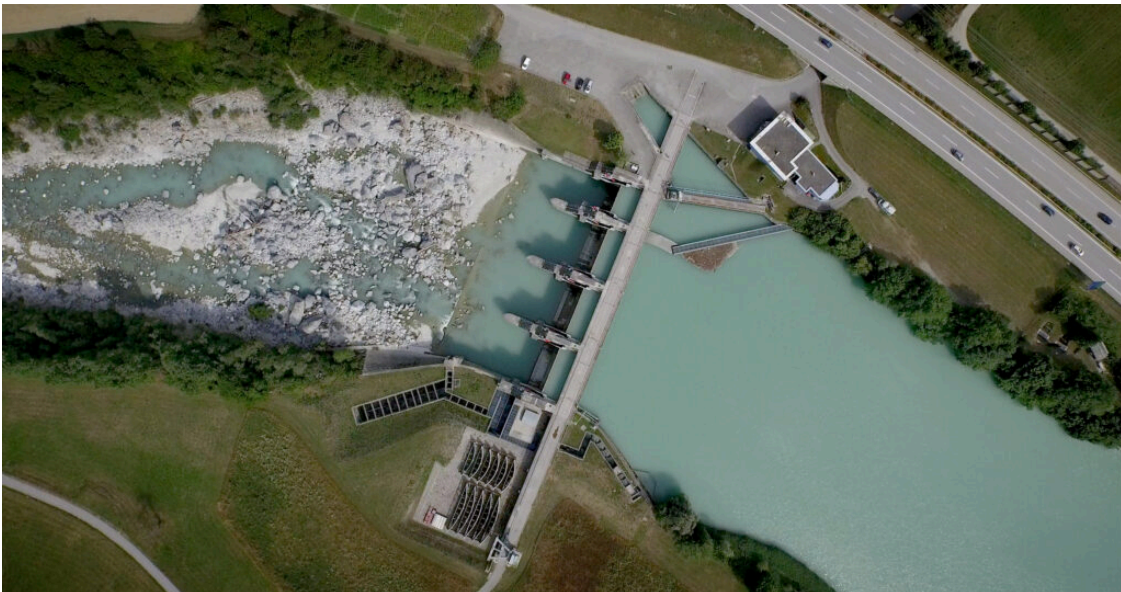
Das Wasserkraftwerk von Reichenau ist das einzige Werk im Alpenrhein.
