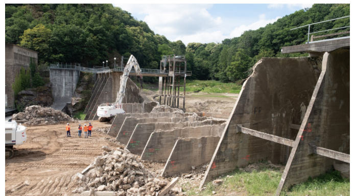
Entfernung des Staudamms la Roche qui boit an der Sélune
