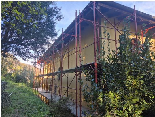
Das Haus ist eingerüstet ...
