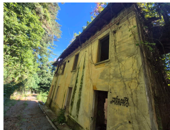
Die Ruine des Pförtnerhauses.
