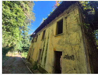
Die Ruine des Pförtnerhauses.
