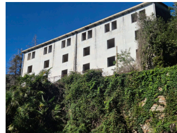
Das Wohngebäude der Bediensteten.
