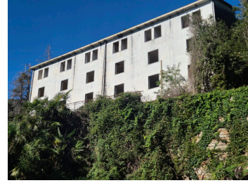
Das Wohngebäude der Bediensteten.
