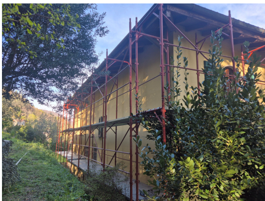
Das Haus ist eingerüstet ...
