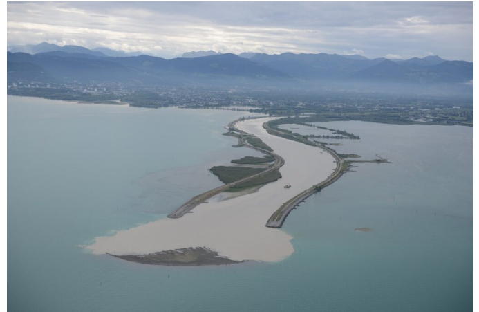
Die Vorstreckung an der Mündung (Foto: Internationale Rheinregulierung).
