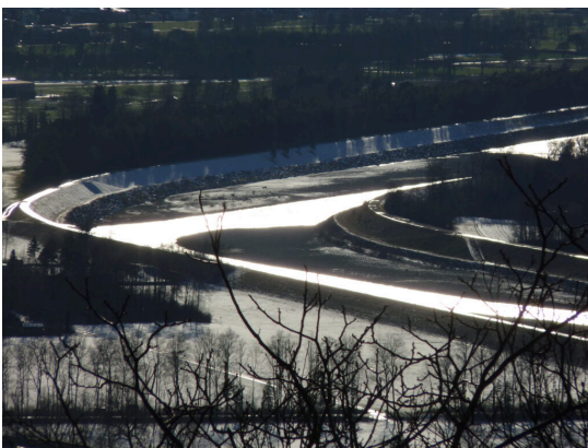
Die Rheindämme ragen teils bis zu 11 Meter über die Talsohle hinaus.
