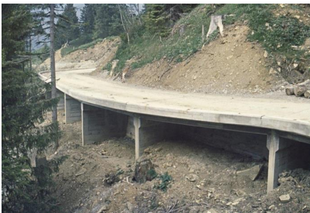
Der Vorantrieb von Forststrassen in steilen Lagen bedingt höhere Investitionen für deren Bau
