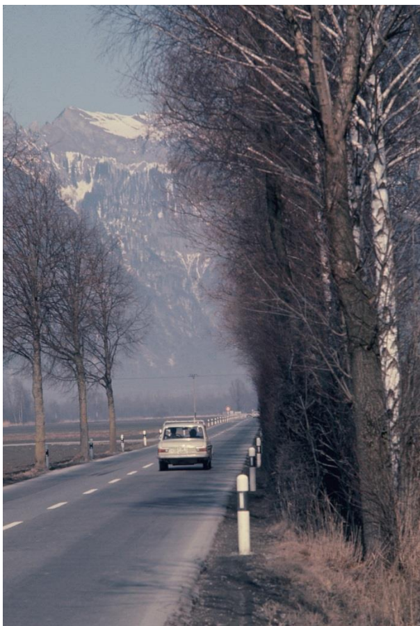
Der Windschutzstreifen an der Landstrasse Schaan-Bendern wurde zu dicht an den Strassenkörper gesetzt und musste in den 1970er Jahren deswegen zu häufig zurückgeschnitten werden.
