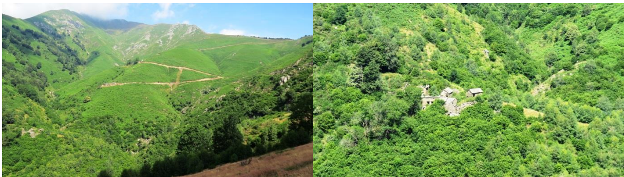
Links: Ein neue Strasse im Bau vom Passo Folungo ins Sgognotal innerhalb des Nationalparkperimeters. Rechts: Von einigen Weilern ist deren Situierung aus landwirtschaftlicher Sicht schwer nachvollziehbar.
