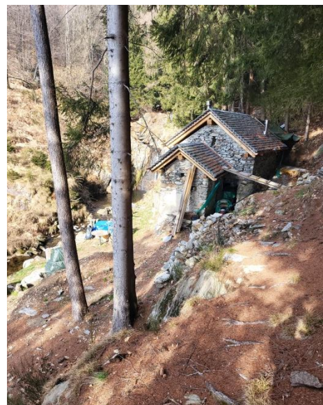
Das in Restauration befindliche Mühlegebäude am Rio Piumsec bei Trarego
