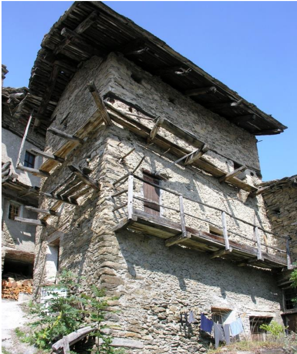
Viele der rund 200 Weiler im Mairatal sind verlassen und die Bausubstanz verfällt
