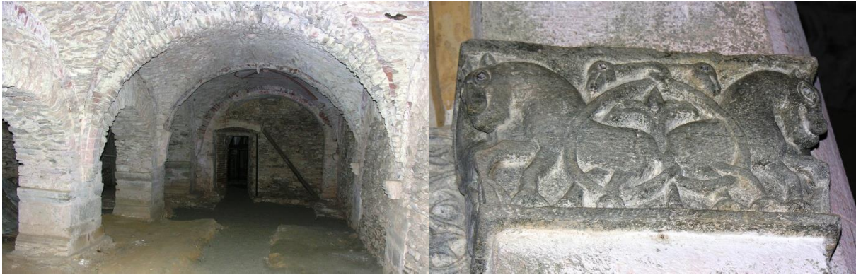
Links: Romanische Bauformen in der Krypta. Rechts: Details an den Säulen der Krypta.
