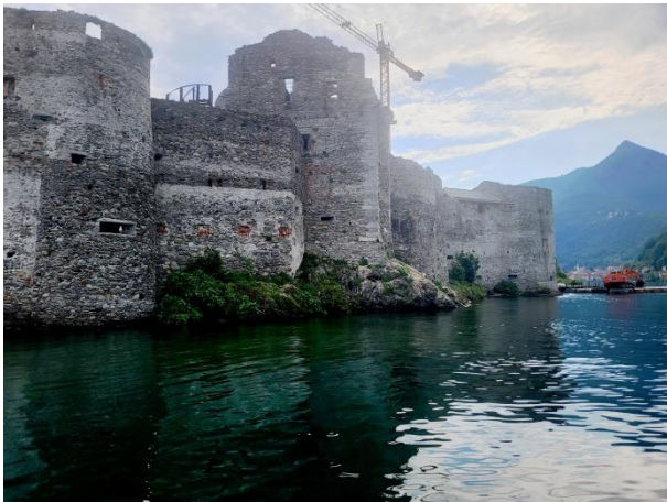
Eingestellte Bauarbeiten und ein verrosteter Kran seit mehr als 20 Jahren ...
