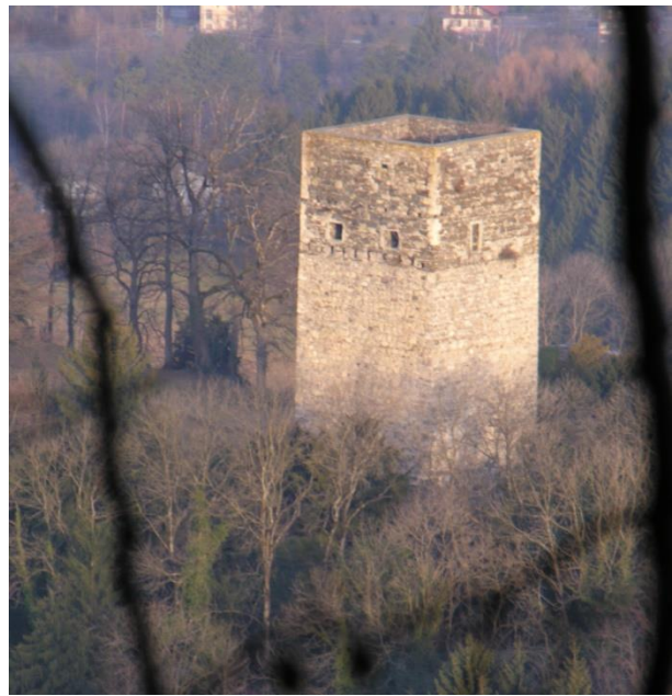
Beim Aufgang erwischt man noch einen Blick auf die Burgruine Tosters, die von den Appenzellern im Jahre 1405 zerstört wurde.
