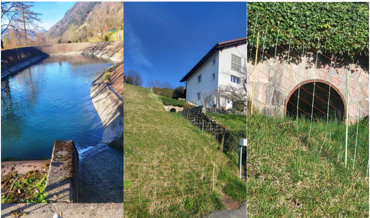
Links: Detail Speicher, landschaftlich nicht unbedingt integriert. Mitte und rechts: Eingangstor des Stollens zum alter Weiher am Rande eines Privathauses am St. Mamertenweg.
