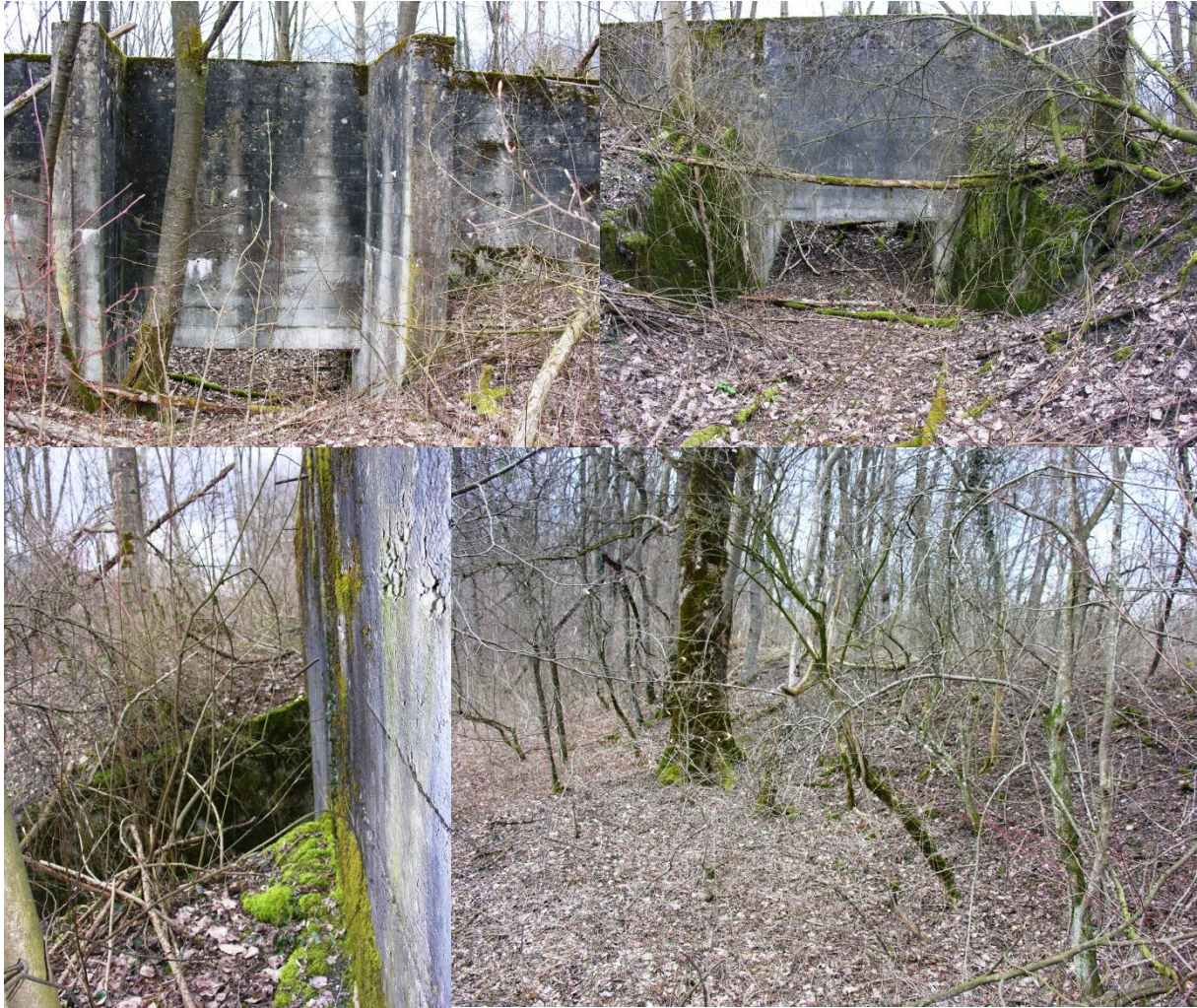
Oben links: Ein markantes, vorerst undefinierbares Bauwerk in den Rheinauen. Oben rechts: Kolmatierungsbauwerk mit Durchlass für das Schwemmgut. Unten links: Detail des Durchlasses. Unten rechts: Kolmatierungsfläche zwischen Rhein- und Binnendamm.
