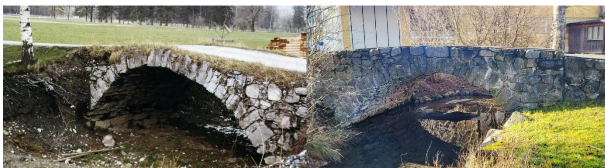
Links: 1985 ausgegraben, präsentierte sich eine schöne Bogenbrücke. Rechts: Die Hochbruck in Balzers, wie sie sich heute präsentiert.
