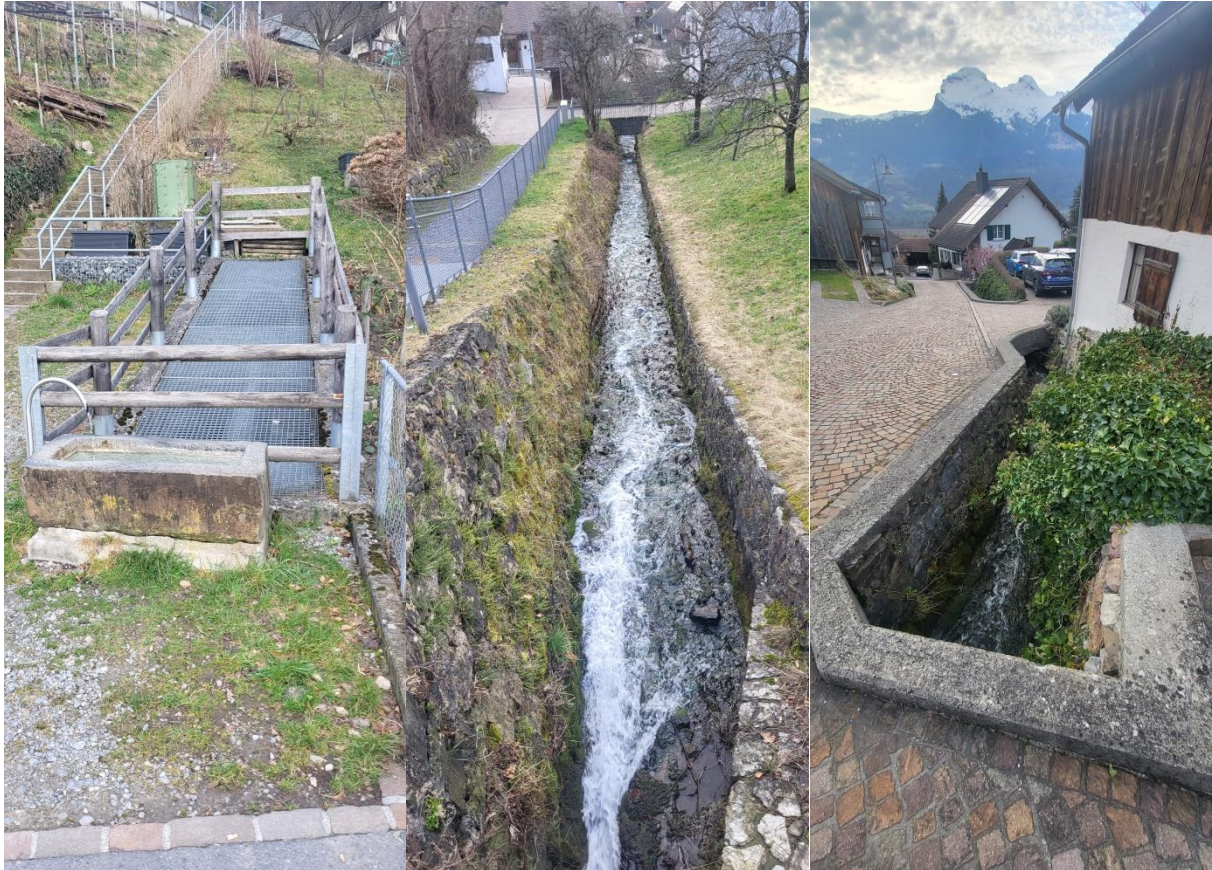
Links: Der Dorfbach beim St.Mamertenweg zeigt sich hinter Gittern erstmals im Siedlungsbereich. Mitte: Stark eingefasst, aber offen zwischen St. Mamertenweg und Oberen Winkel. Rechts: Seine letzte offene Kurve in Richtung Säge.
