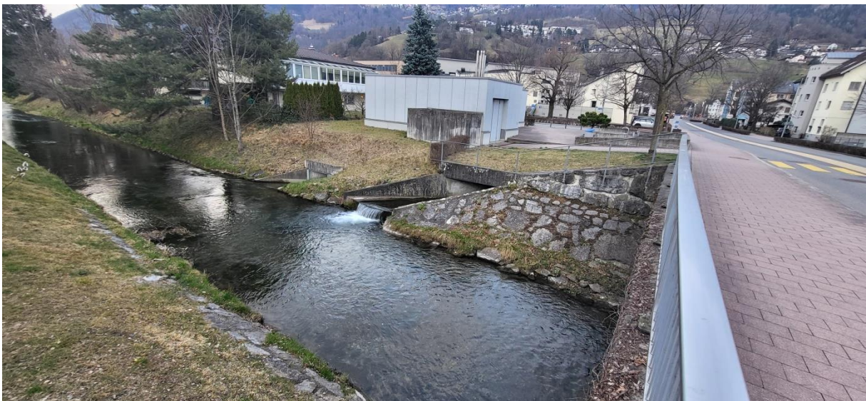
Eine unrühmliche betonöse Mündung in den Binnenkanal.
