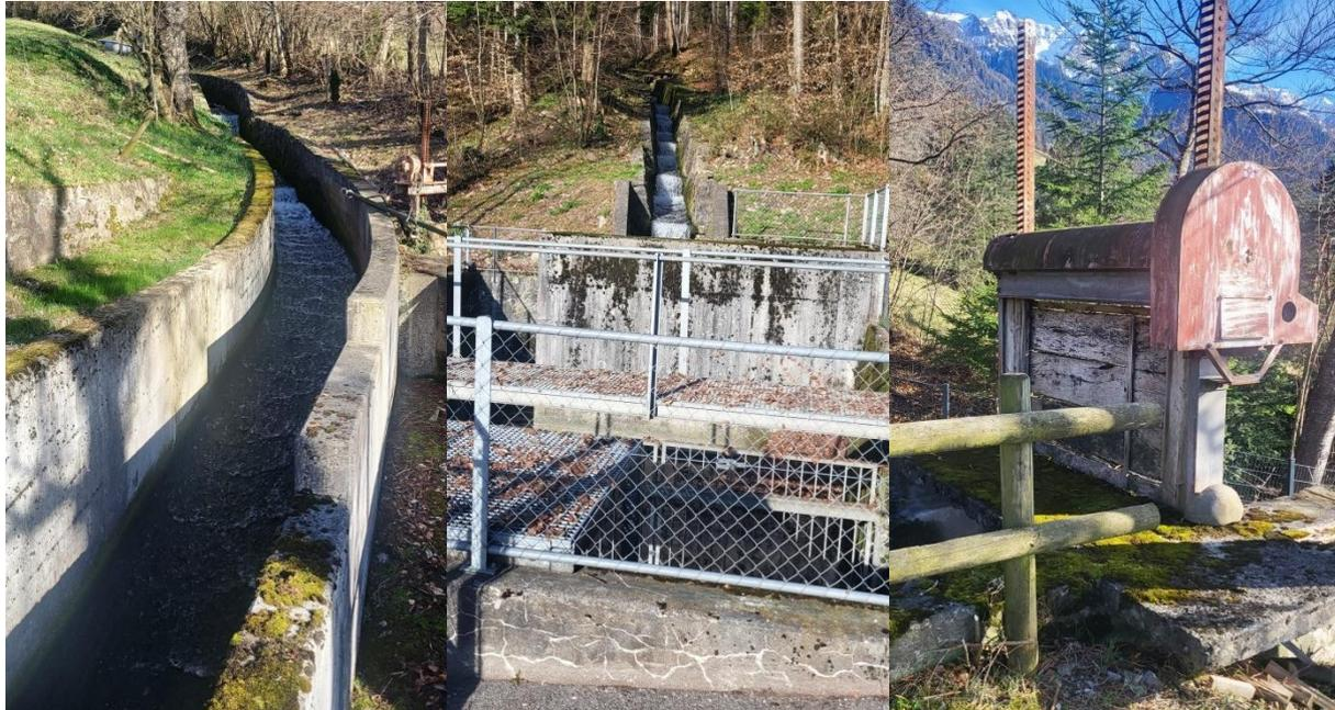
*Dem Speicherbecken auf Letzana zugeführte Gewässer (links und Mitte); Alte Schiebereinrichtungen der Wasserzufuhr zur Druckleitung.*
