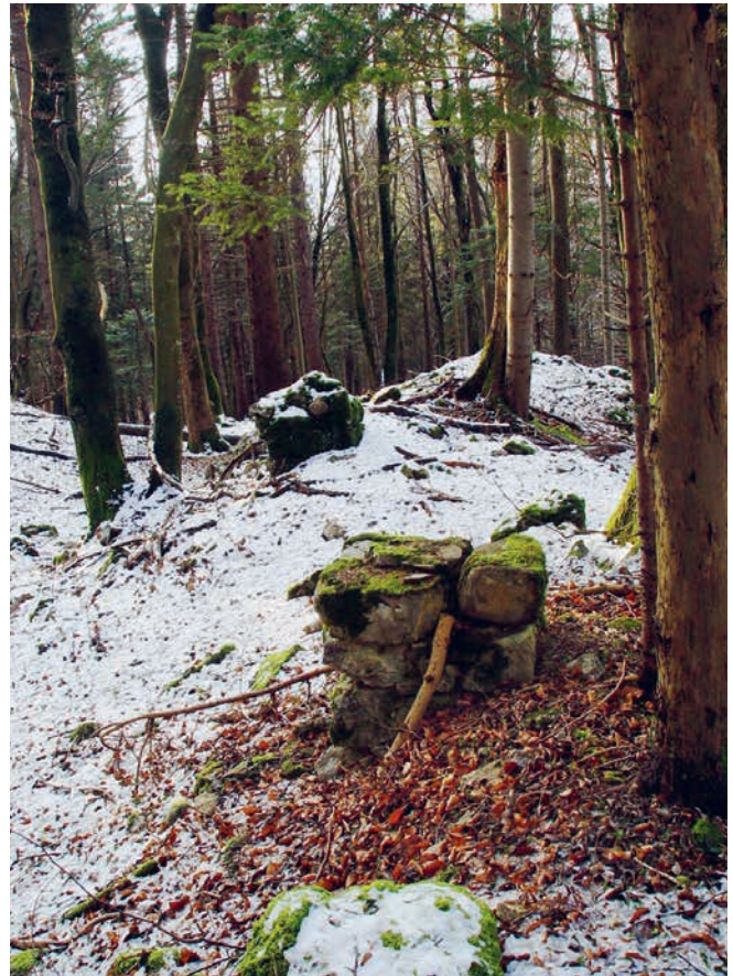
Abb. 19: Die Ruinen des Bauwerks sind in eine Märchenlandschaft mit markanten Bäumen eingebettet.
