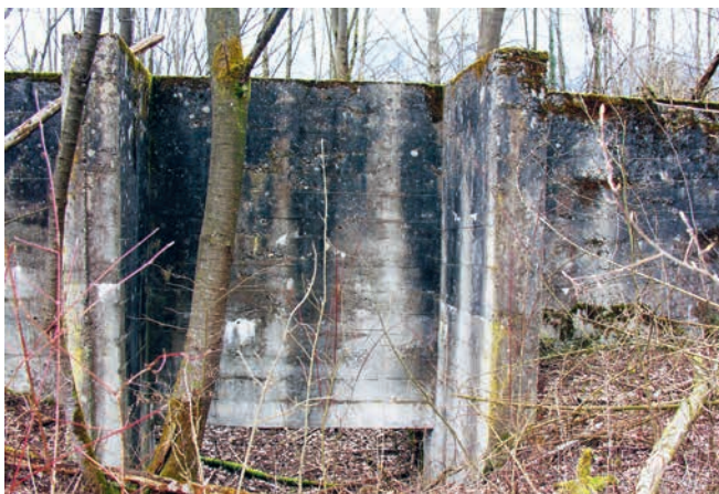
Abb. 71: Ein markantes, vorerst undefinierbares Bauwerk in den Rheinauen.
