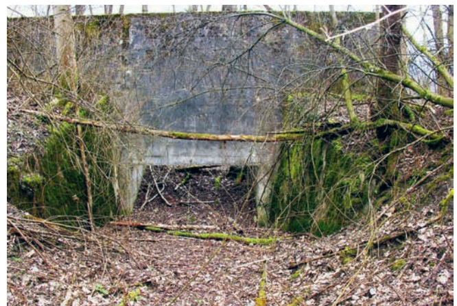
Abb. 72: Kolmatierungsbauwerk mit Durchlass für das Schwemmgut.
