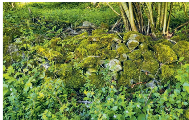
Abb. 30: Wenige Steinmauerabschnitte sind noch intakt.
