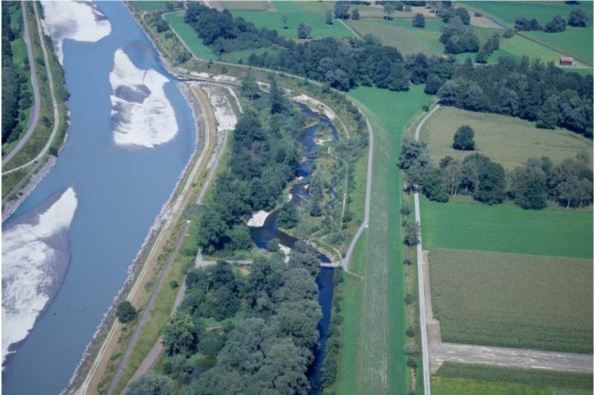
Neugestaltung der Binnenkanaleinmündung (Foto Planaqua)
