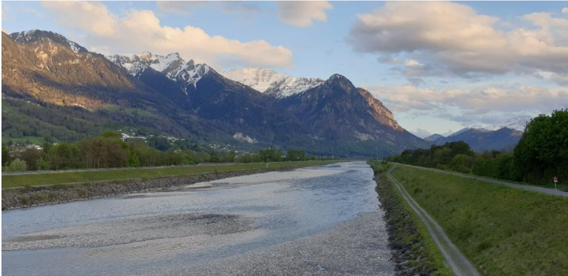
Der Alpenrhein ist auf seiner ganzen Länge in ein trapezförmiges Normalprofil eingezwängt (Foto Christian Göldi)
