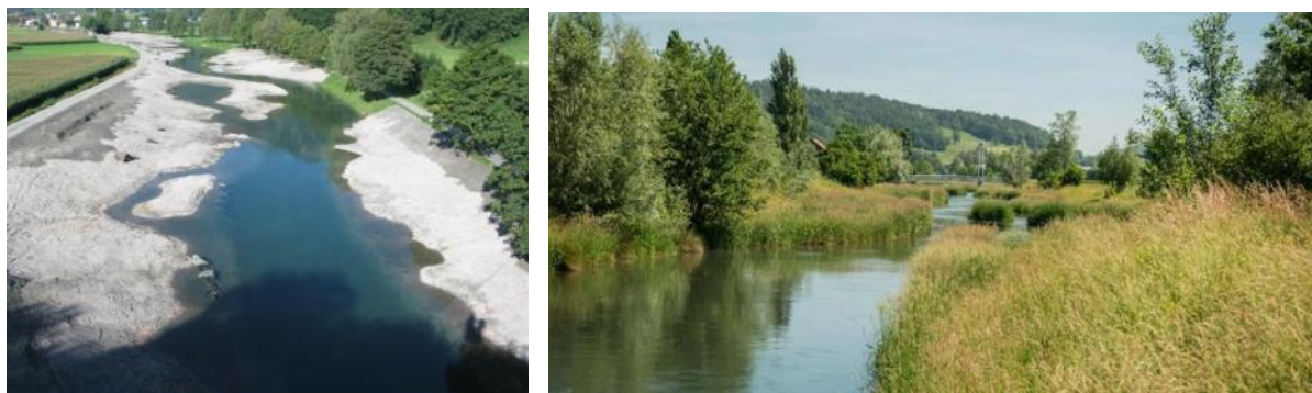
Ausweitung Rheintaler Binnenkanal bei Rüthi SG nach Fertigstellung (Foto Bänziger Partner AG) und Jahre später (Foto Gemeinde Rüthi)
